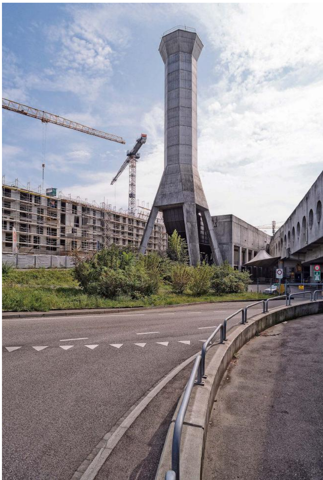
Es heisst Abschied nehmen: Der Lüftungsturm muss verschwinden.
